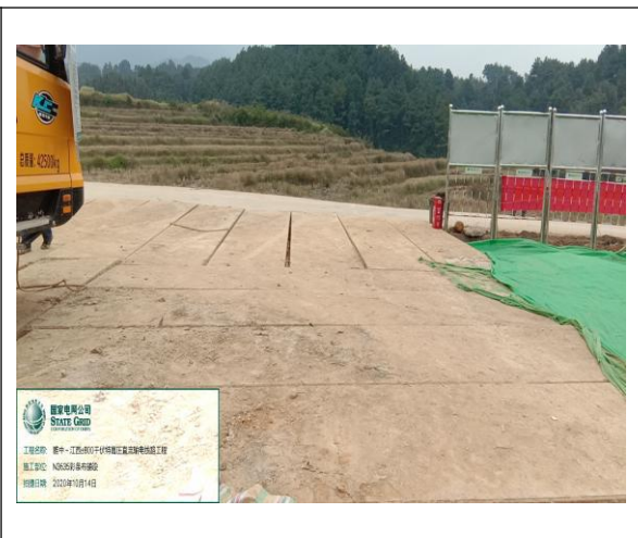
施工道路临时钢板铺垫
